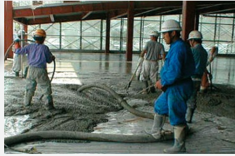
生コン打設状況
