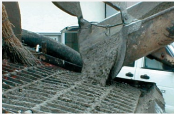
アジテータ車よりポンプ車へ生コン排出
