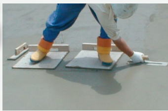
金ゴテにて最終表面仕上げ
