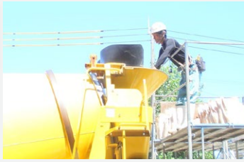
作業足場にバルチップを積載し投入の段取りをする
