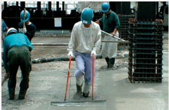
タンピングによるバルチップの押え状況
