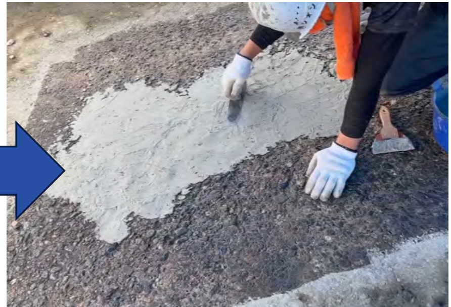
HI-SPECシール1層目塗布後に、 HI-SPECシールL+P固練材にて 断面補修を行う
