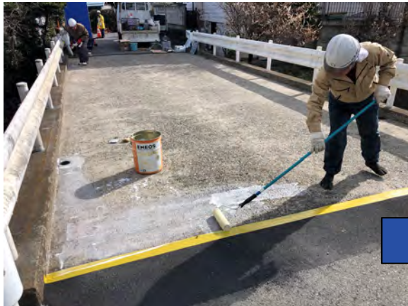
AM 9:15 HI-SPECシールL (CPタイプ)塗布開始
