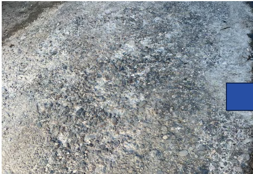
施工前の舗装の状態
