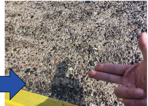
AM 10:50 HI-SPECシールL (CPタイプ) 指触乾燥確認
