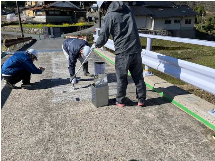
高浸透型床版防水の施工状況
