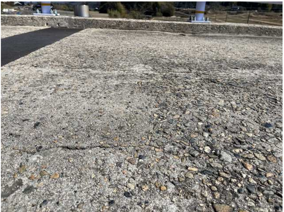
亜硝酸リチウム塗布後の状況
