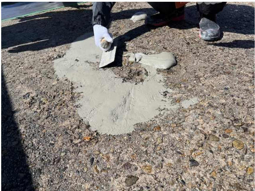
防水層保護工の施工状況
