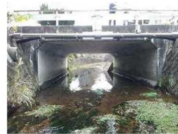
写真-2 対象とした橋梁
