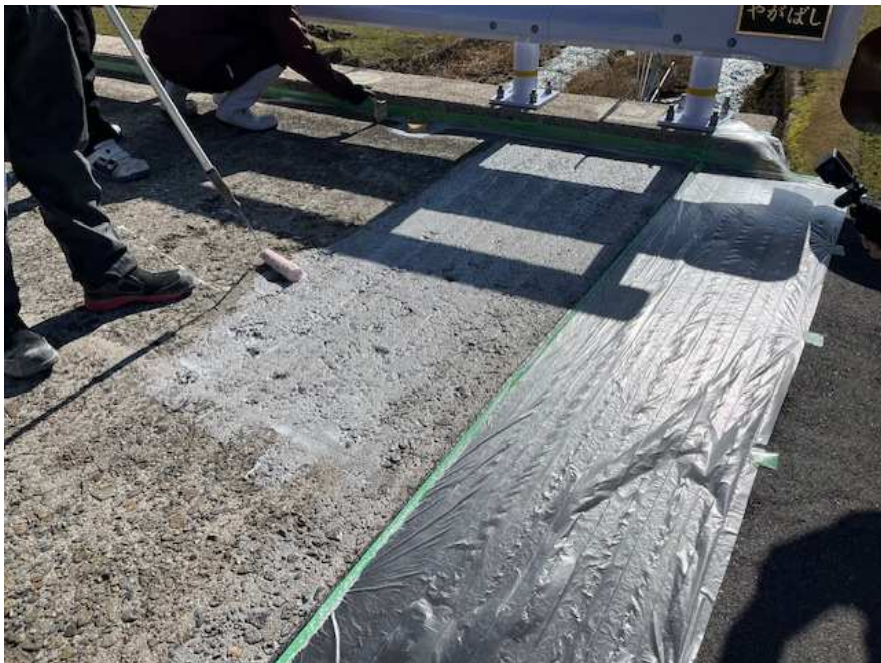
高浸透型床版防水の施工状況
