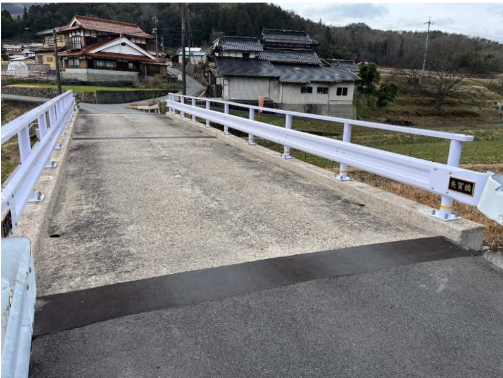
亜硝酸リチウム塗布後の状況
