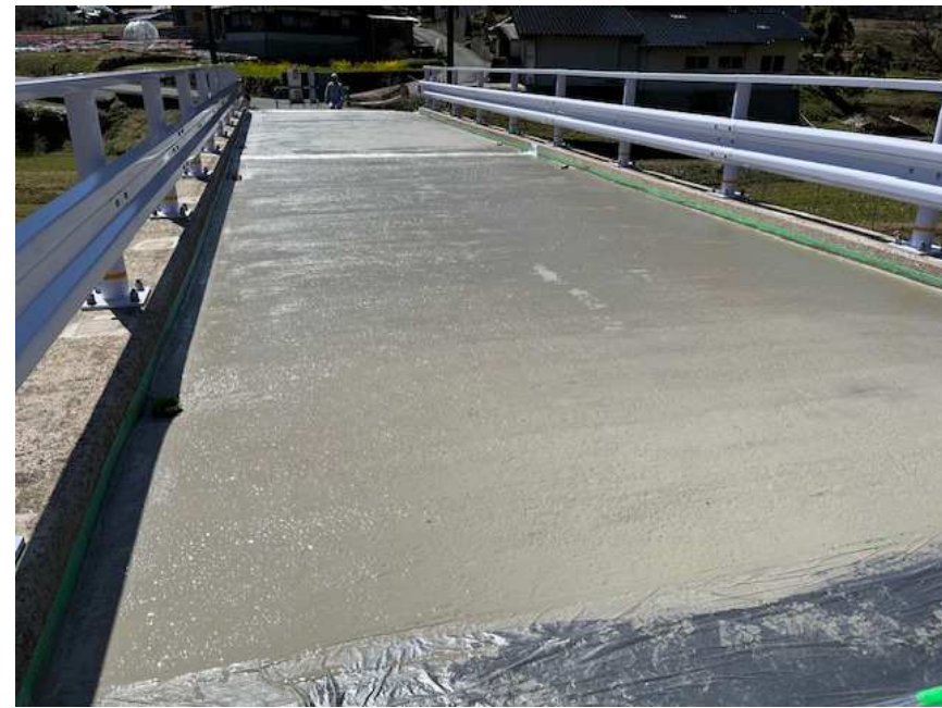
防水層保護工の施工状況
